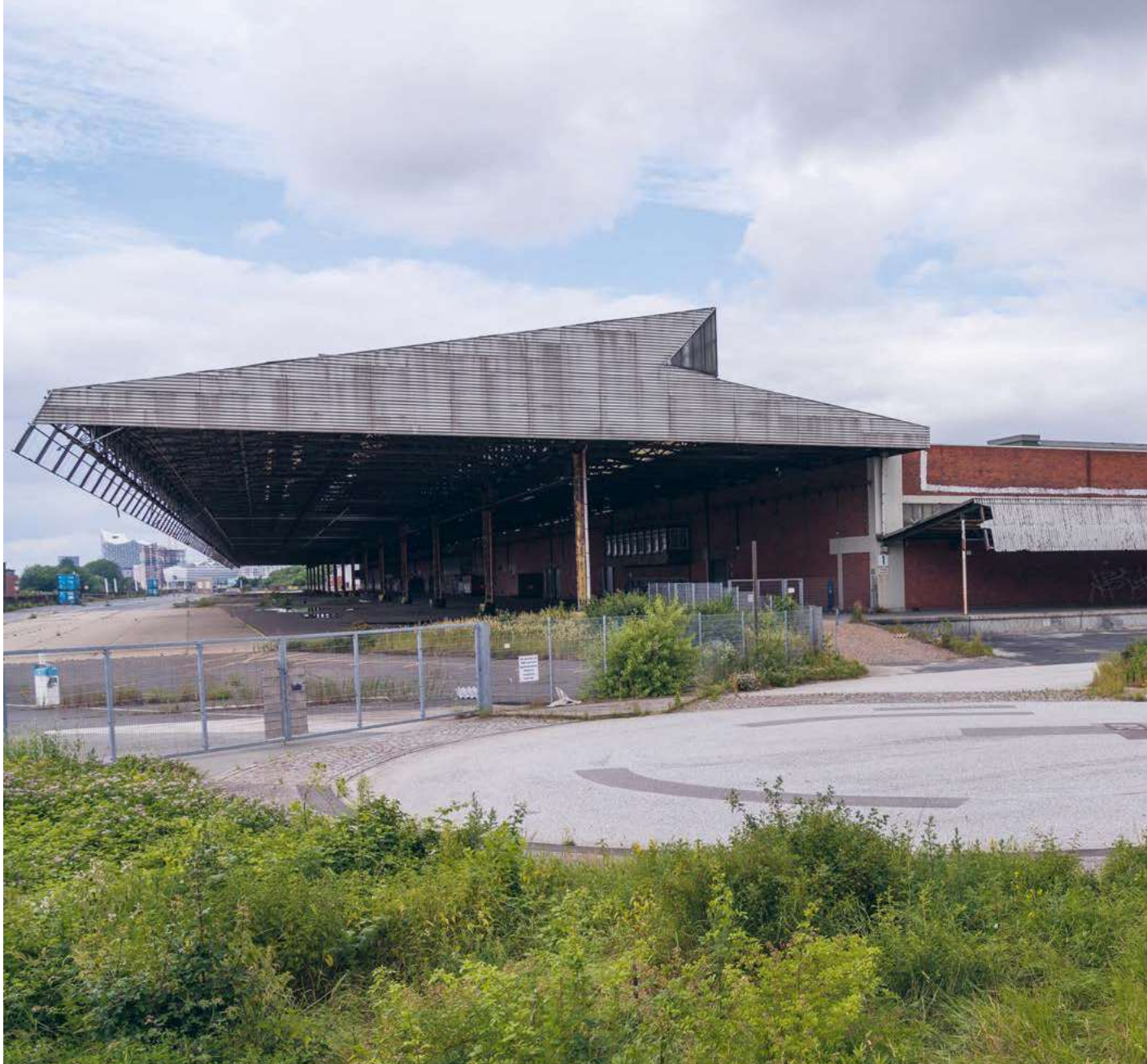
Das große Schleppdach des Überseezentrums vor dem Abbruch (Foto: Thomas Hampel)
