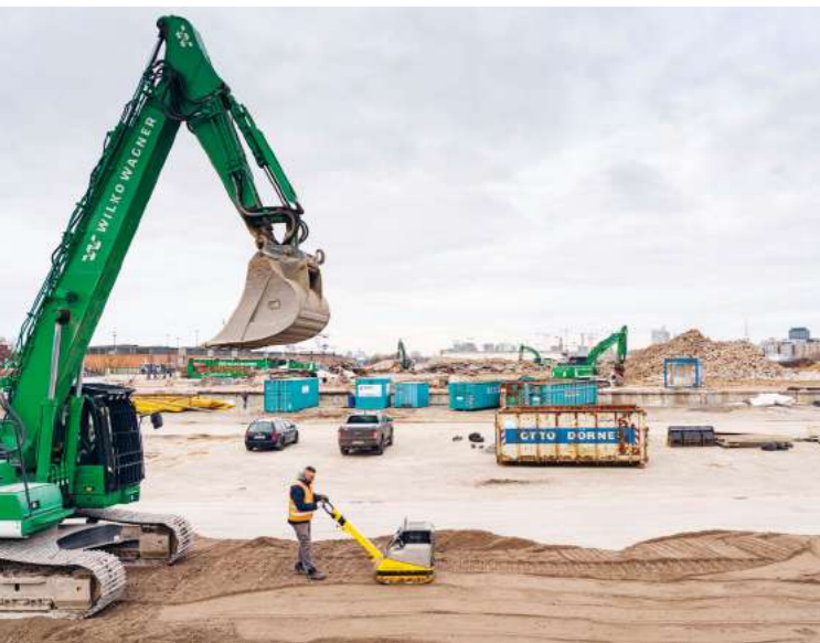
Demolition work at Überseezentrum 2022 (Photo: Thomas Hampel)
